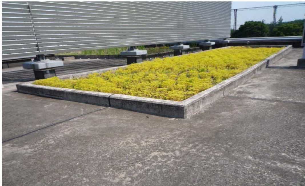
小平庁舎の屋上緑化
