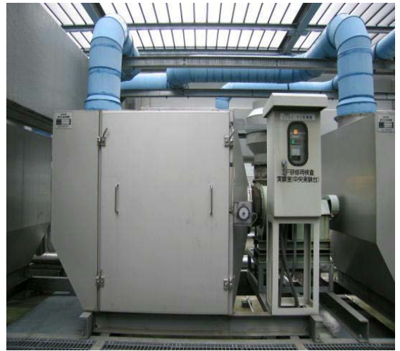
活性炭式脱臭装置 (乾式スクラバー)
